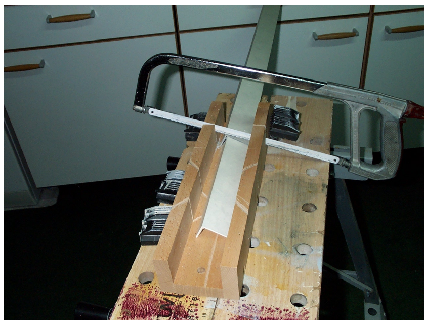
Découpe des cornières alu pour le châssis.
